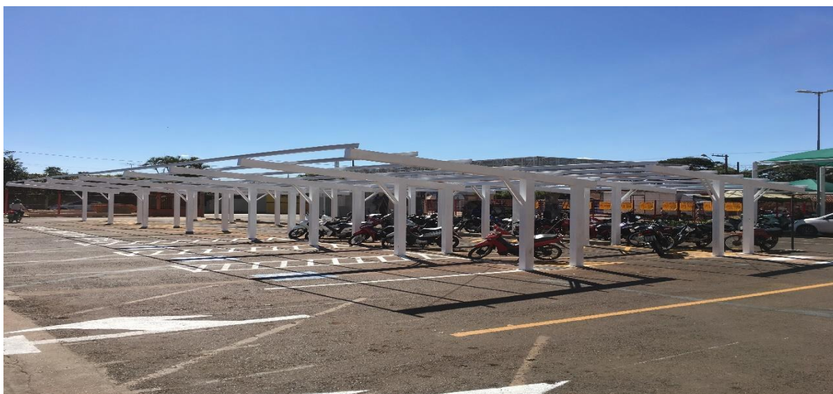
FIGURA 2. Cobertura das garagens com placas geradoras de energia solar. Fonte: Imagem fotografada pelos autores (2019).
